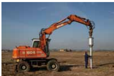
Unkomplizierte Installation der Bohrfundamente. Einfaches Einbohren mit einem Hydraulikbagger.
